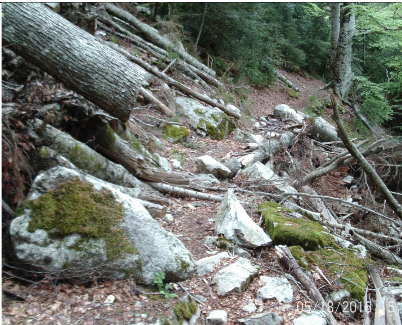
23- Abatis juste avant l'éboulement (sens Ouest vers Est)- stabilité au-dessus du chemin ?
