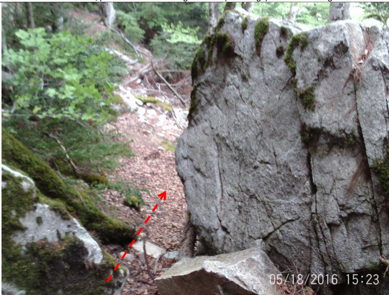
22- Quelle est la stabilité au-dessus du chemin ?
